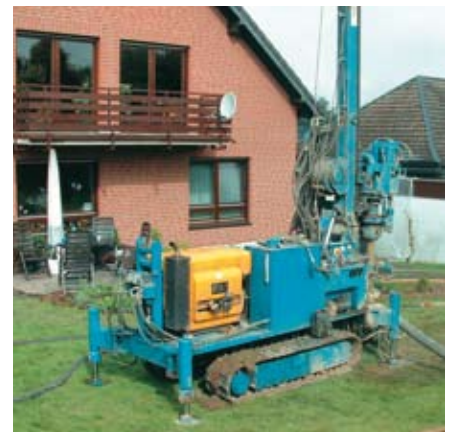
Bohrung für Erdwärmesonde
